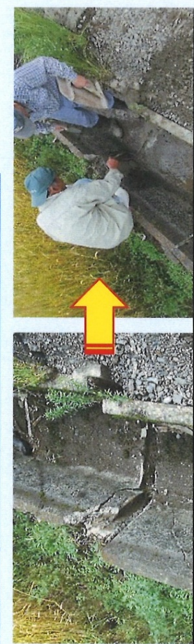
地震により破損した水路を地域共同で補修（外注も可能）
