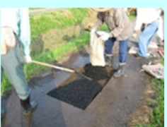
農道の部分補修
