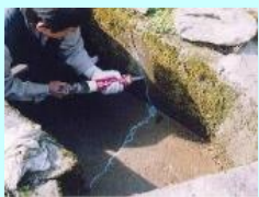
水路のひび割れ補修
