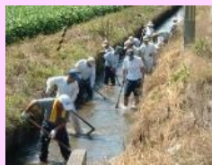
水路の泥上げ
