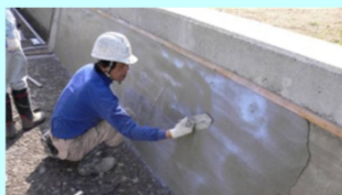
老朽化した水路壁のコーティング
