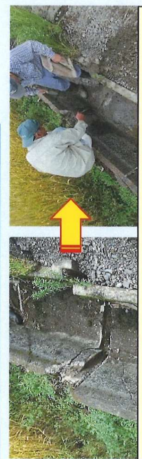
地震により破損した水路を地域共同で補修（外注も可能）
